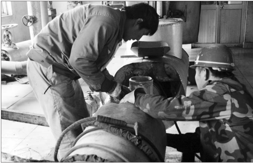
在潍坊昌能热源有限公司, 工人正在更换管道的阀门。 本报记者 孙国祥 摄
