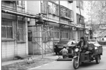
工作人员正在为供热管道贴膜。
