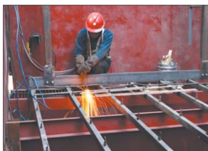
在一即将投入使用的大型脱硫设备中,工作人员正在焊接零部件。
