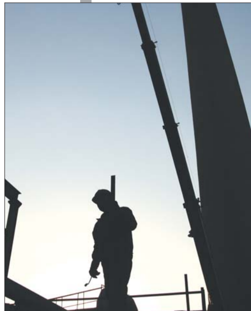
工作人员抓紧最后时间安装设备。
