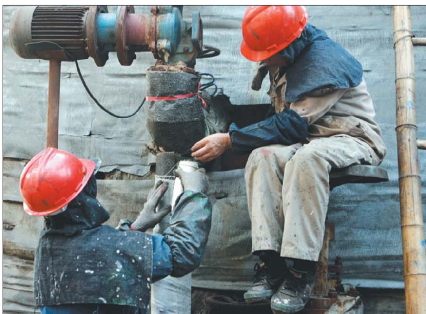
两名工作人员正在用保温材料将供暖管道包好。
