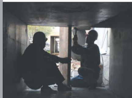
两名工作人员正在焊接管道。
