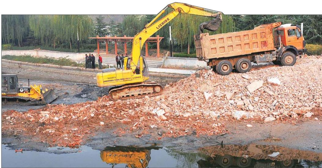
▲大型挖掘机已经下到河底,正在进行清淤。本报记者 邓兴宇 摄
