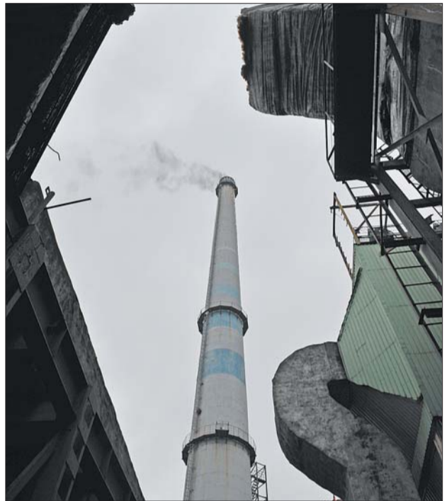
济南热电南郊热电厂储煤充足,目前,锅炉早已加负荷运行。 本报记者 周青先 摄
