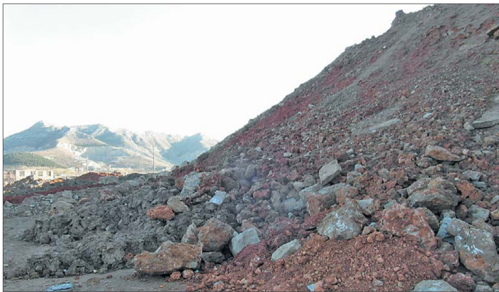
兴隆山水库南岸,成堆的建筑渣土。 本报记者 张嶺 摄
