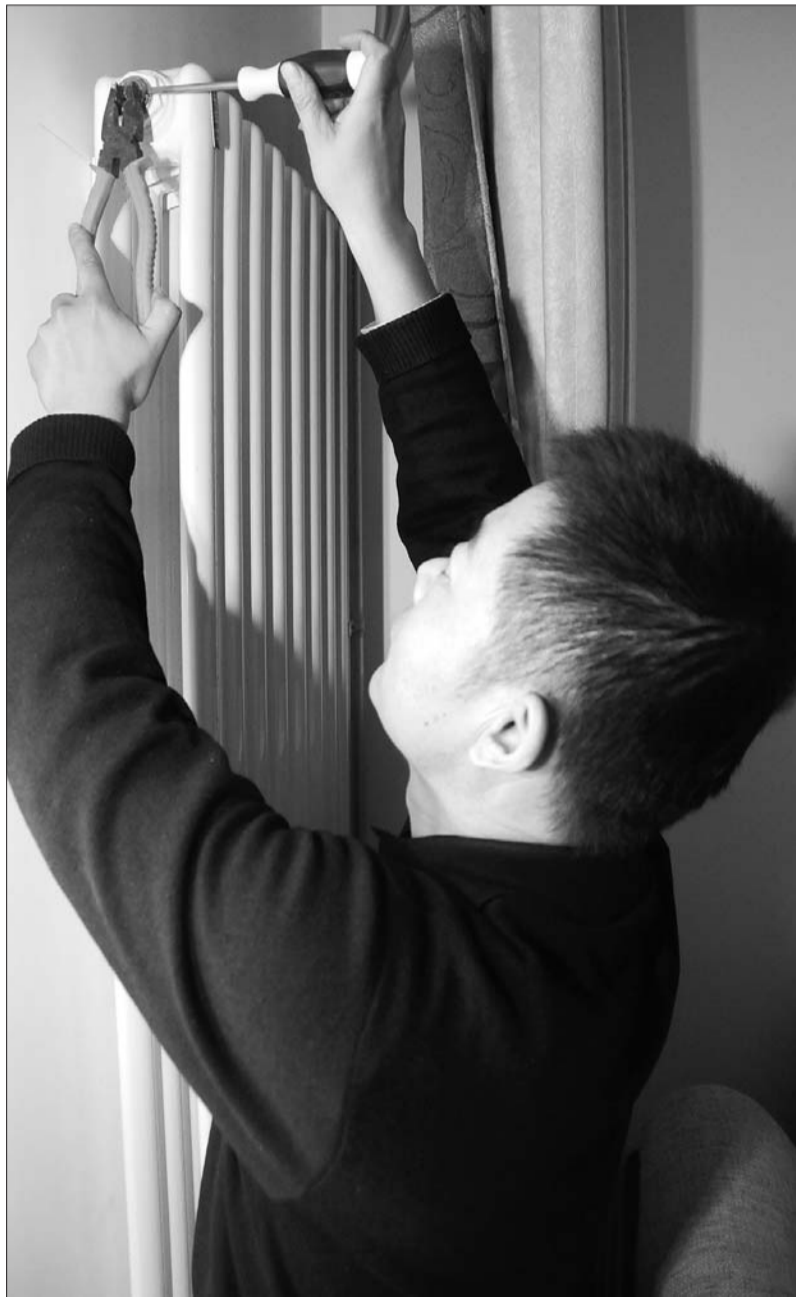
郭勇来到业主家帮忙检修暖气管道。 本报记者 邓兴宇 摄
