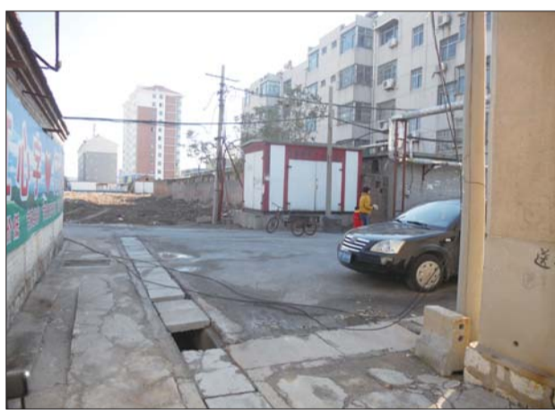
小区内掉落的电线和破损井盖经常妨碍居民出行。 本报记者 于荣花 摄
