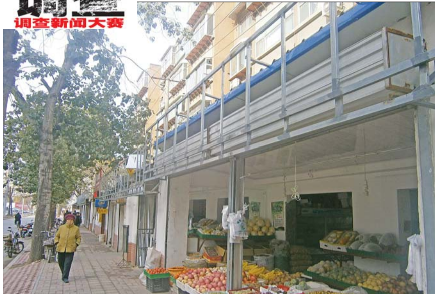
刘长山路不少沿街店铺的旧广告牌已经拆除,新支架已经做好。
