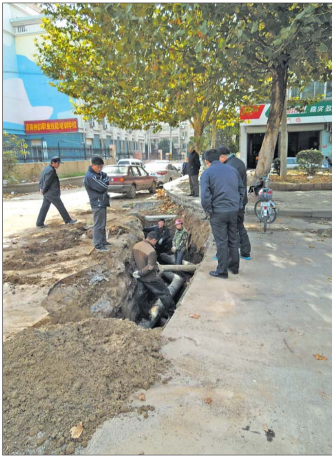
玉函南区新区的供热管道已经铺设完毕,有一小段正在微调。 见习记者 刘雅菲 摄
