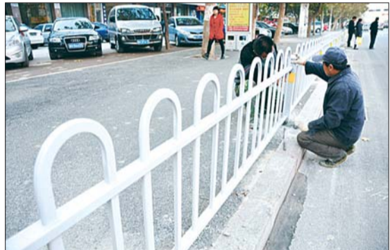
工作人员正在拆卸护栏设置开口。李岩松 摄
