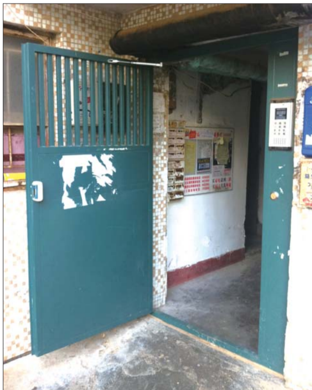
许多单元楼的防盗门就这样敞开着。 记者 尹海涛 摄
