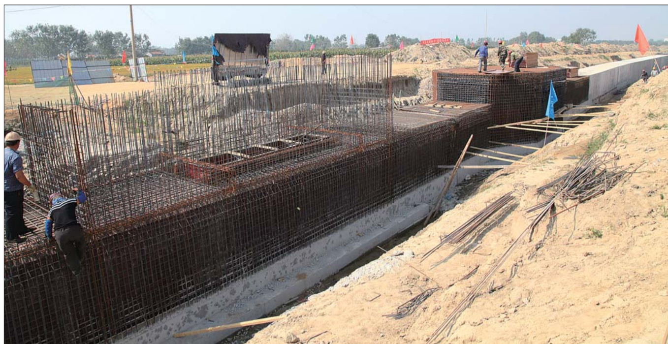
10月份,日照国际海洋城总长0.95公里的地下双舱综合管廊已开工建设。(日照国际海洋城供图)
