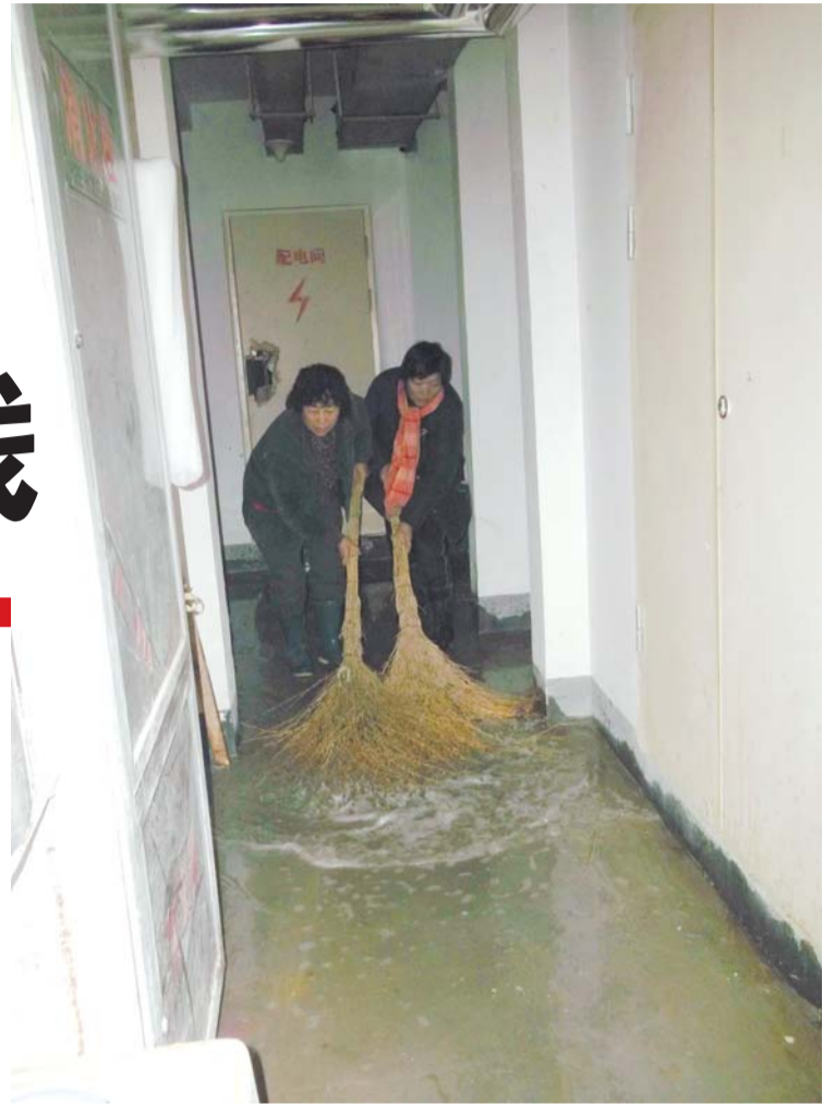
15日,位于山东财经大学燕山校区南门附近的学府蓝山小区B3号楼1单元充水试压,11楼暖气管道漏水,大量的水顺着楼道和暖气井向下淌。当天,济南正式开始集中供暖,但由于供热管网、设备故障等原因,不少居民家中并没有按时热起来。 本报见习记者 朱洪蕾 摄
