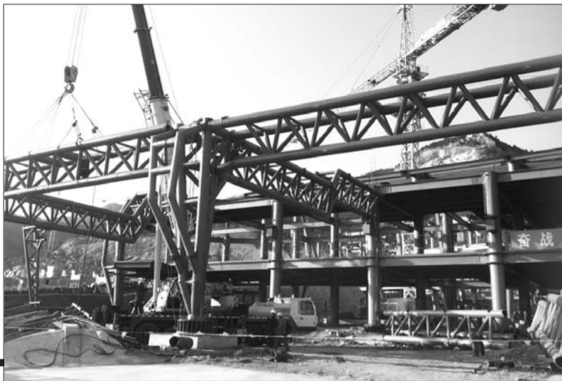
世园会主题馆正在施工建设中。
