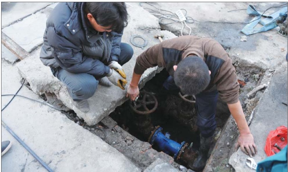
15日,一小区物业正在积极抢修供暖管道。 本报记者 李运恒 摄
