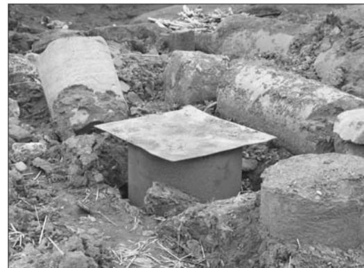
完工的水井,井口已被封上。
