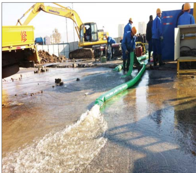
抢修人员在排水。
