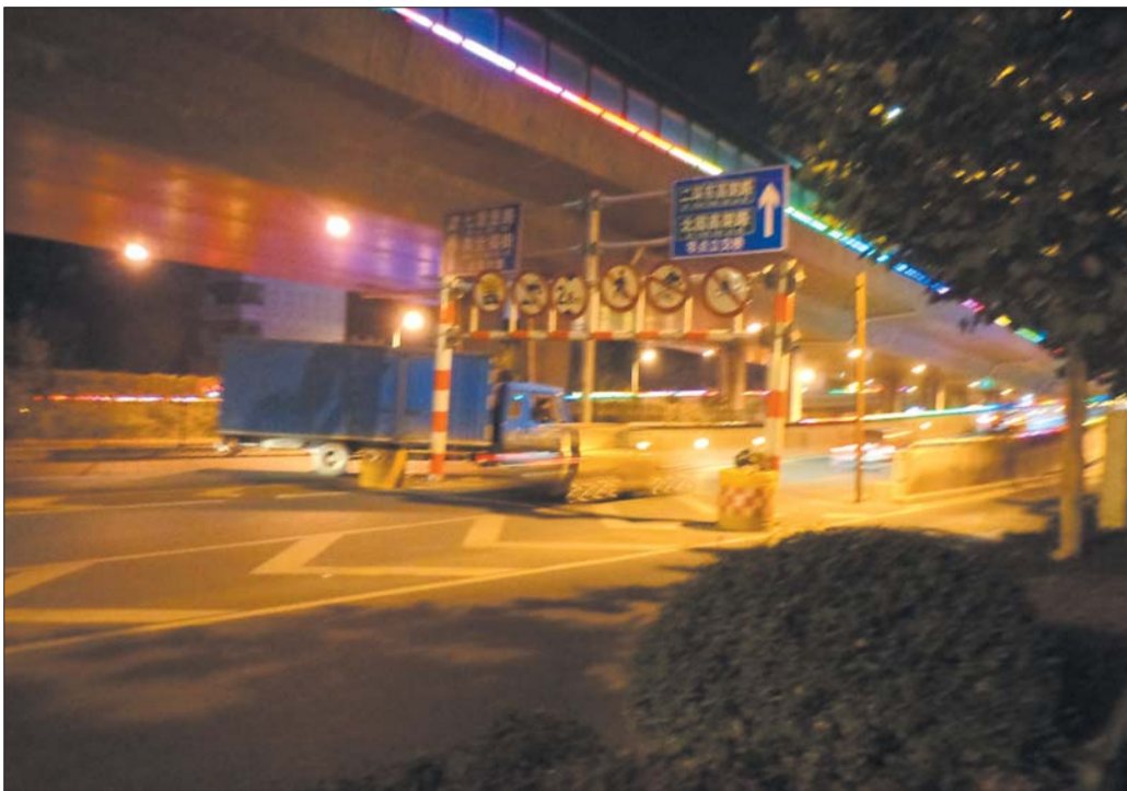
一辆超出限高杆的货车正钻过空隙上高架桥。 见习记者 叶嘉利 摄
