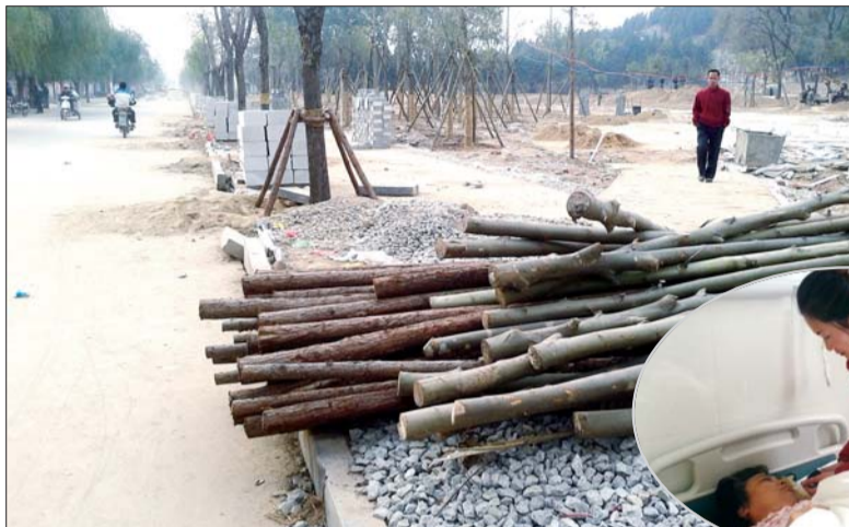
◀路边堆放着施工材料,还有市民频繁经过。
