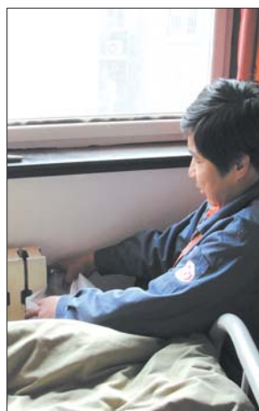
维修人员为暖气排气。记者 蒋慧晨 摄
