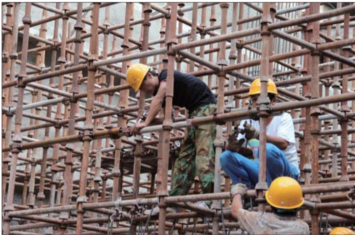
地铁工人正在加紧施工。
