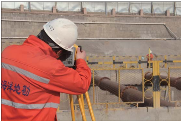
大年初一,青岛地铁留守人员进行沙土沉降监测。
