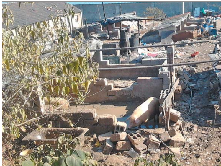
前魏华村的“泔水猪”养殖场限期10日内由养殖户自行无害化处理。 本报记者 陈伟 摄
