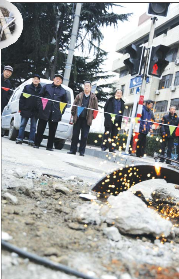
▲大海阳路上,工作人员正在抢修,焦急的市民在路边观看进度。记者 李泊静 摄
