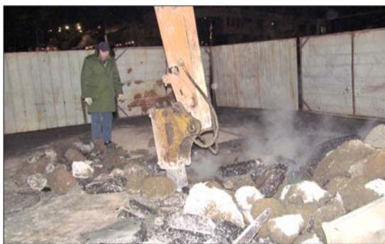
▲工作人员连夜破开混凝土路面。图片由通讯员提供
