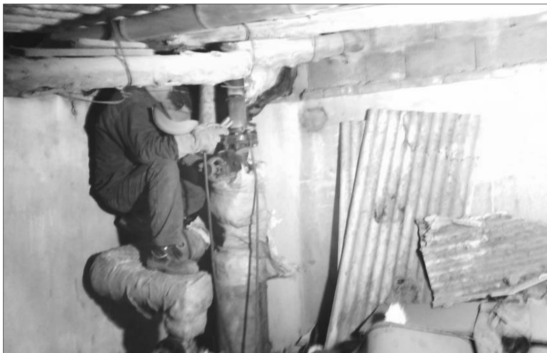
抢修工人抓紧时间焊接被切管道。 本报见习记者 李芳 摄
