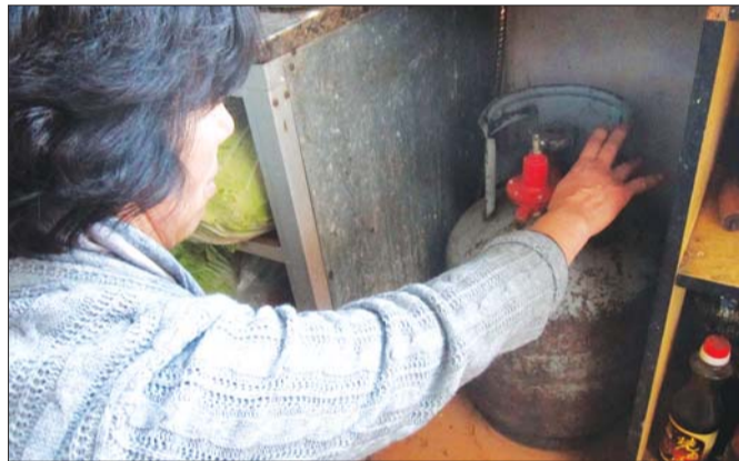
西山路潘女士家的液化气罐用了约10年,罐体已锈迹斑斑。记者 曲彦霖 摄
