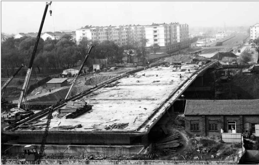
正在建设中的三八路运河桥处于规划之中,目前该桥主体完工,正在做桥面铺设。见习记者 王小会 摄
