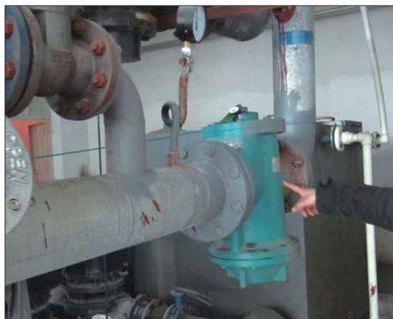
物业工作人员指着加装在供水管道上的流量控制阀。 本报记者 李玉涛 摄
