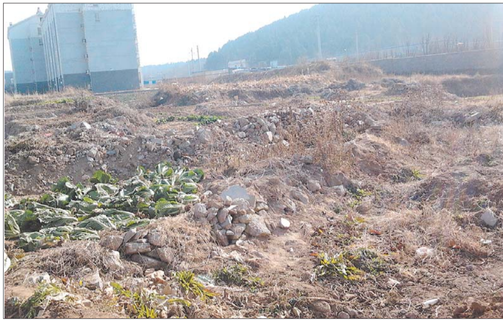
长清区经济适用房雅居花苑小区的5号、6号楼,四年未动工,已杂草丛生。本报记者 陈伟 摄
