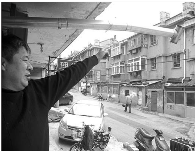
▲烟台一居民在烟囱上安装的三通, 可防煤气倒灌。
