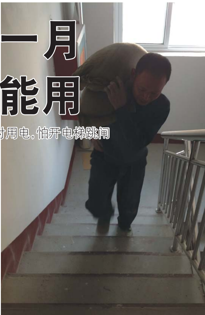
电梯没法用,只能将装修材料扛到楼上。
