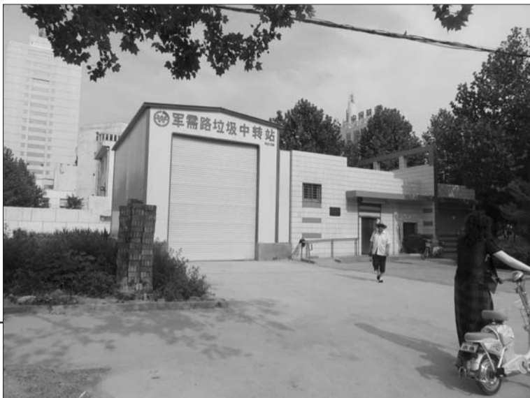
新建设的压缩式垃圾中转站。
