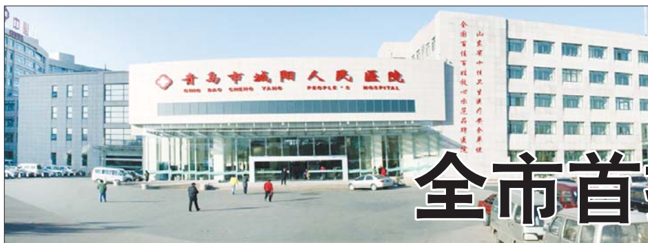
青岛市城阳人民医院全景。
