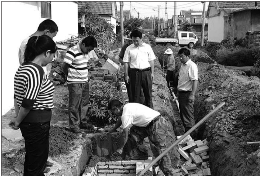
张成森在自来水管铺设现场指导施工。(资料片)
