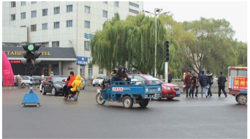
东岳大街华侨大厦路口,固定信号灯不亮,临时信号灯只有白天“值班”。
