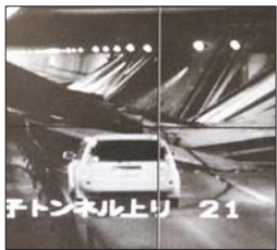
隧道监控捕捉的坍塌现场画面。
