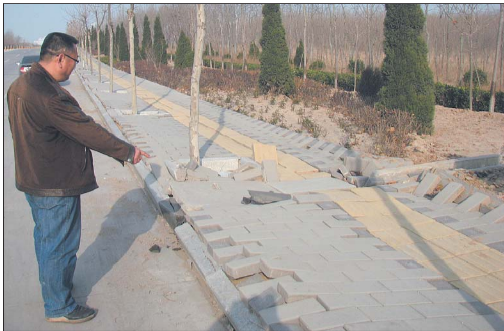
下沉路段附近的地砖和路沿石凸了起来。 本报记者 王永军 摄
