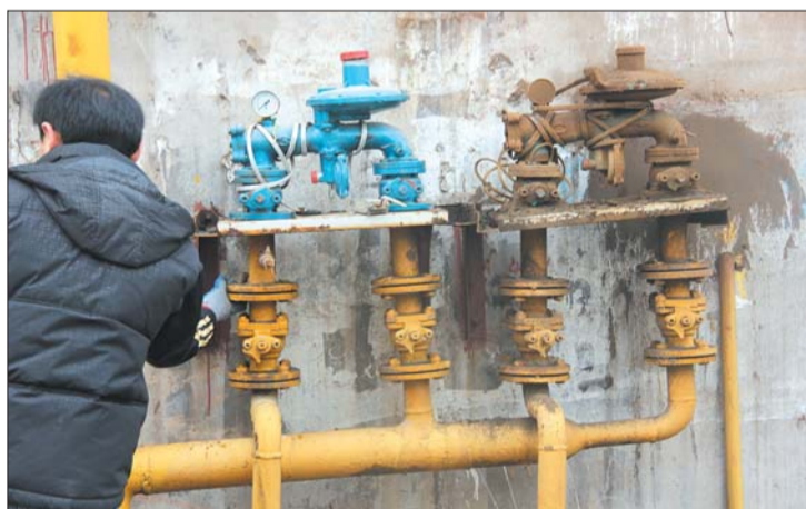
维修人员正在对煤气管道进行维修。 本报记者 刘帅 摄
