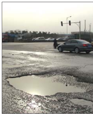
温泉路与外环路交界处,污水外溢。本报记者 王世腾 摄
