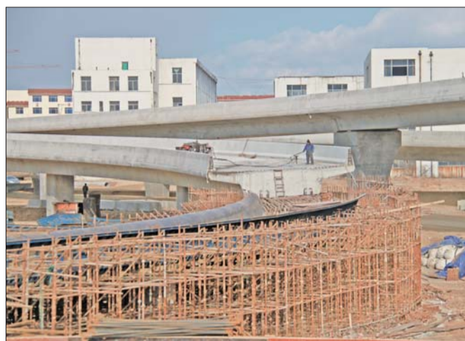
建筑工人在桥面进行修整。记者 王震 摄
