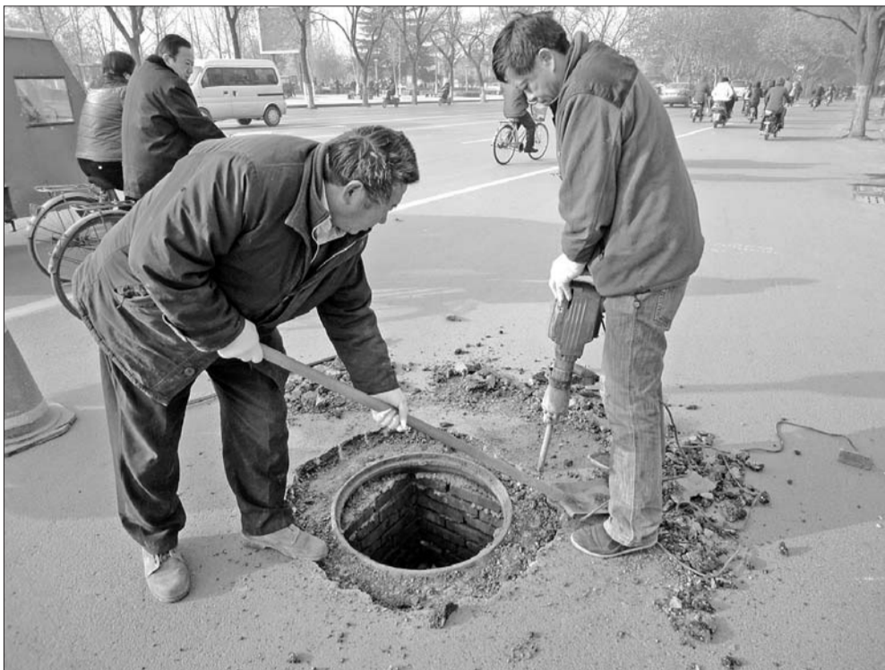
►维修人员正在更换新井盖。 见习记者张林 摄
