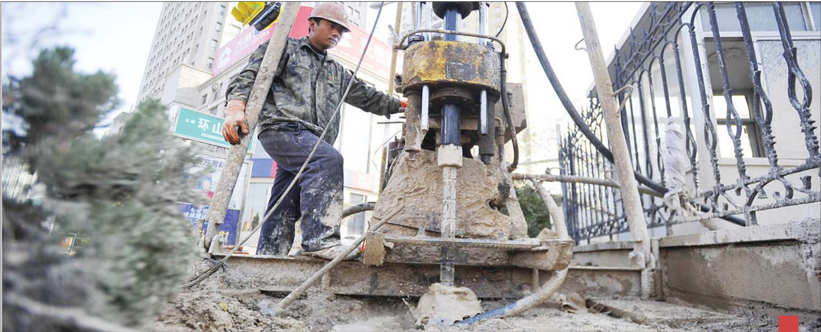
钻探第一步:用钻机进行地下钻探。
