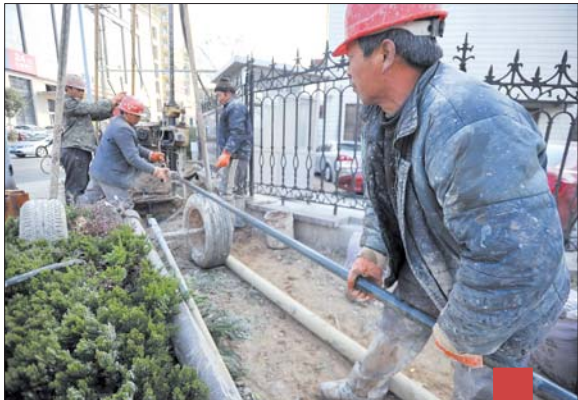
钻探第二步:将钻机的钻杆取出。
