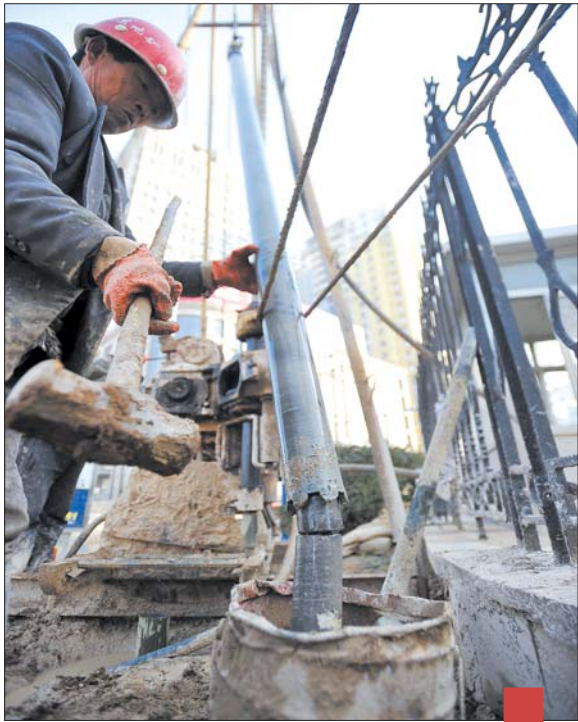
钻探第三步:将岩石从岩芯管内敲出来。
