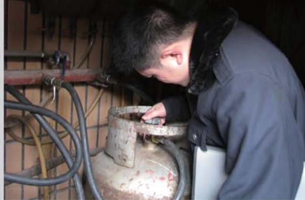
执法人员检查液化气罐的检验标示。
