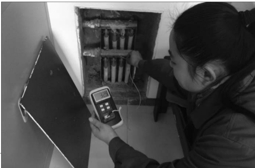
热力公司工作人员正在对用户家中管道进行测温。 本报记者 李晓东 摄
