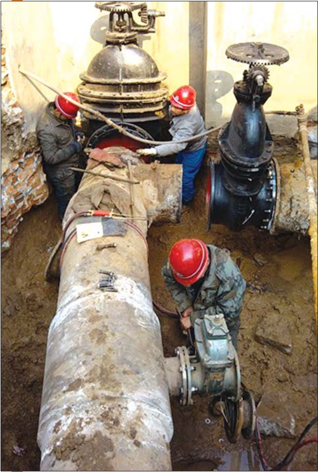
工人更换主管道的阀门。 本报记者 王世腾 摄
