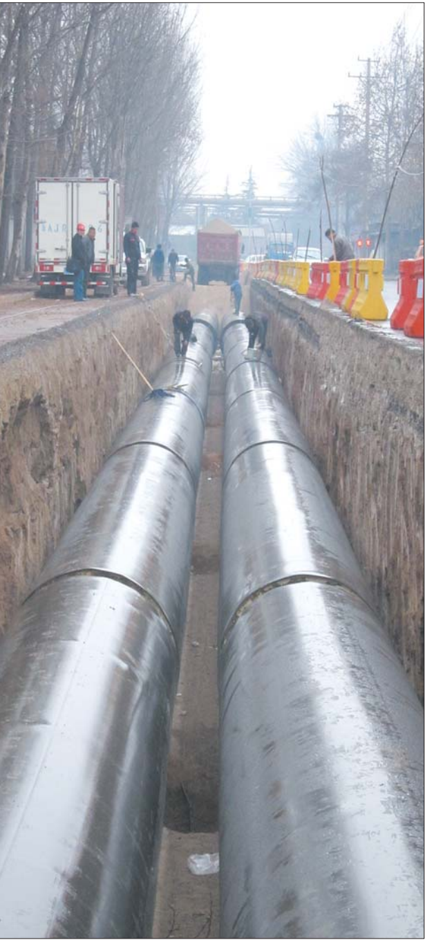
钢化路上,济南热力公司施工人员正在铺设供热主管网。该管网起点为济钢余热热源点,终点为工业北路,全长1.2公里。 本报记者 王光照 摄
