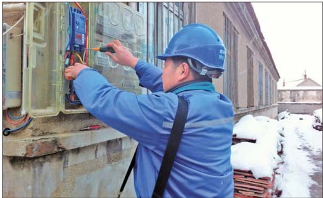
威海供电公司工作人员为村民检查低压供电线路及电表箱。
