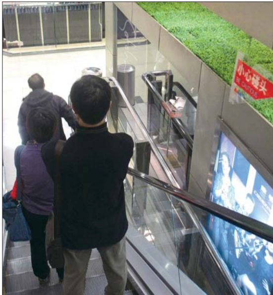
张店区柳泉路上一大型商场自动扶梯“剪刀口”处,仅挂着“小心碰头”提示牌。
