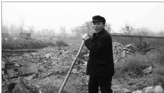
11日村民正在拆除危旧房屋。(通讯员供图)
